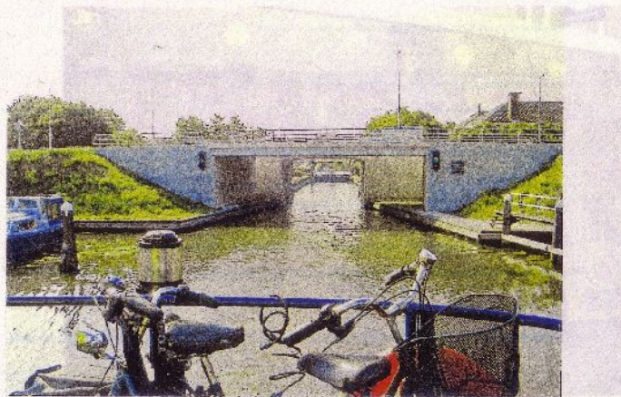
運河の開門の出入り口には船用の信号機があり、音になったら進む。
